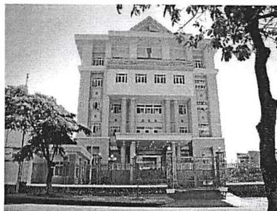
Công trình Ngân hàng Nhà nước Kon Tum
